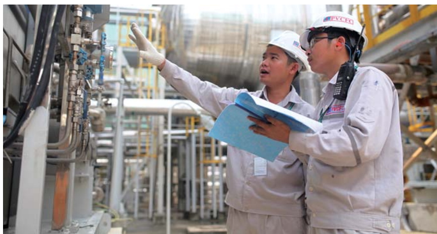
Trao đổi kinh nghiệm sửa chữa và vận hành tại Nhà máy Đạm Cà Mau. Ảnh: PVCFC
